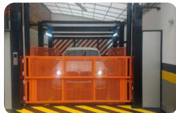
Edificio Katios - Bogotá
