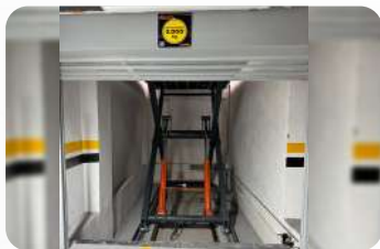
Edificio Krystal - Pasto
